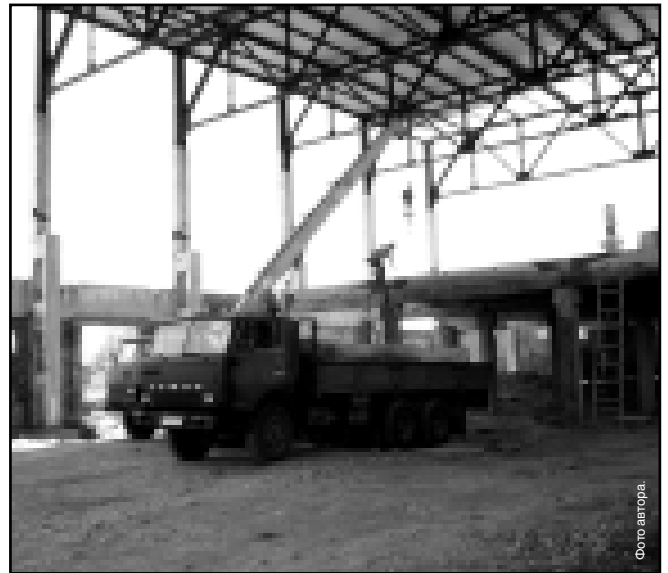
Строители завершают монтажные работы в цехе готовой продукции.
