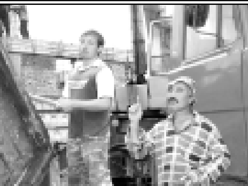
Сиз бу суратта кереги Османланы Исса бла Залим бетон ишледе урунады. Болсаа ала керек заманда киргич да салалды, шуткурат да этмедиле. Исса абаданыраакы, жаш тегену курулушу ичин усталгыны жашырылыгына юйрөттөдү.
