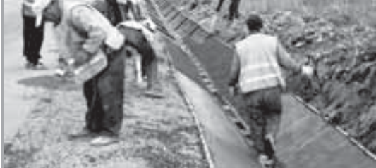
Бетонирование коветов на автодороге Кисловодск – Джилы Су, 6.06.2013 г.
