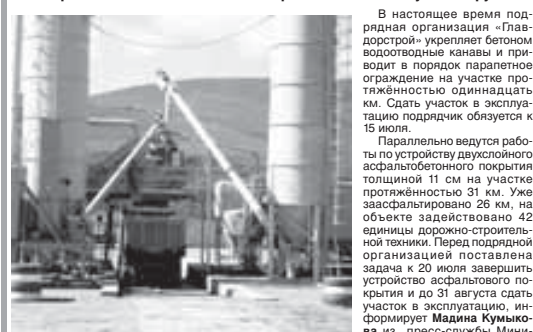
Отпуск асфальта с нового асфальтобетонного завода в с. Кичмалка, 6.06.2013 г.
