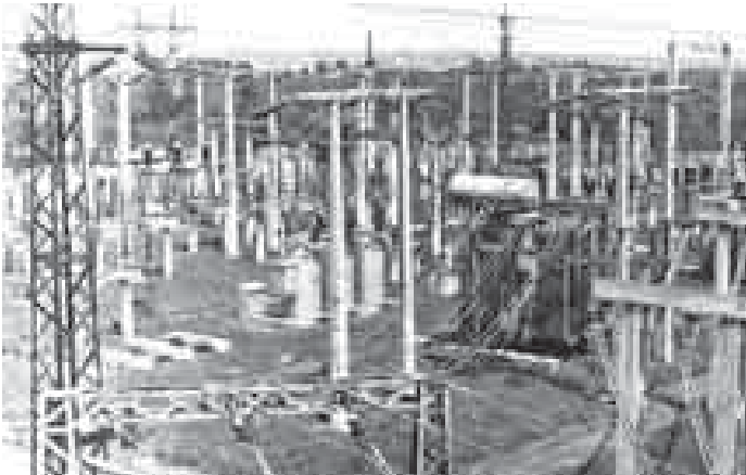
Подстанция «Нальчик», 1973 г.
