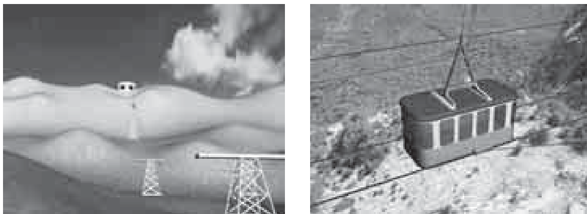
Рис. 2. Общий вид грузопассажирской канатной скоростной дороги
