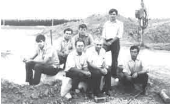
На строительстве кабельного завода, 1971 год
