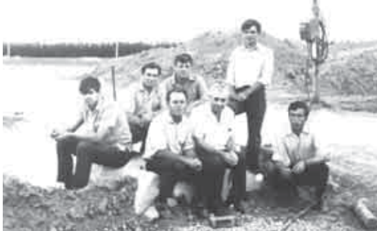
На строительстве кабельного завода, 1971 год
