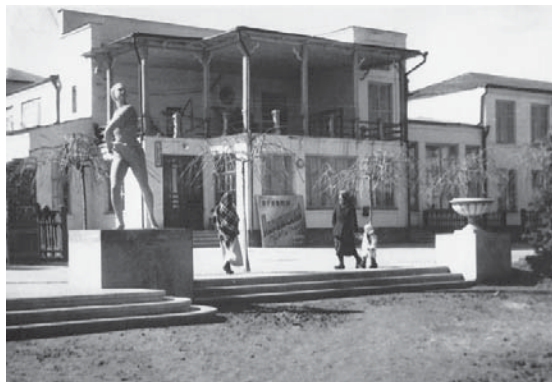
Здание драматического театра в Нальчике, 1938 г.
