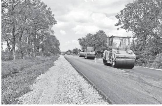
участке дороги. Дорожная лаборатория проверяет химический состав и упругость материала, толщину слоя асфальтобетона. Работа идёт на упрёждение: постоянный контроль позволяет достичь высоких результатов, а вовремя сделанный ремонт позволит дороге прослужить дольше.
