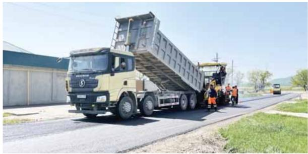
ит немало: построить выравнивающий и верхний слой покрытия из щебёночно-мастичного асфальтобетона, поресечения, примыкания и тротуары, укрепить обочины дороги и обустроить её – нанести разметку, установить
