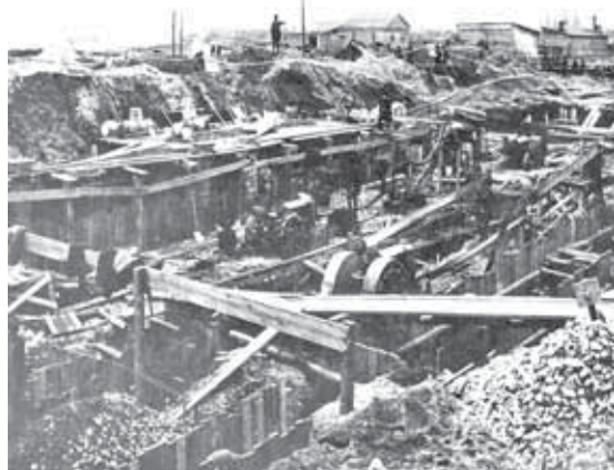
Строительство Баксанской ГЭС, пос. БаксанГЭС. 1932 г.
