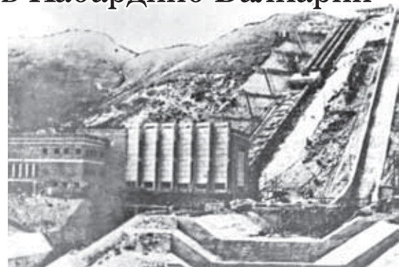
Строительство Баксанской ГЭС, пос. БаксанГЭС. 1936 г.
