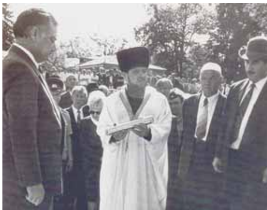
Торжественная церемония закладки фундамента соборной мечети. Председатель Духовного управления мусульман КБР Ш.А. Пишибаев (в центре), Президент КБР В.М. Коква (слева), министр архитектуры и строительства КБР С.Т. Кучмазоков (справа), г. Нальчик, 1994 г.
